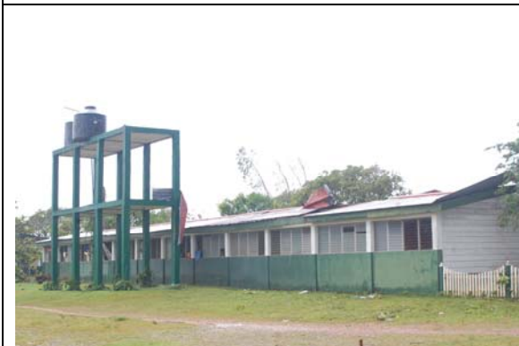
Pabellón de Aulas y Sistema de Agua Potable
