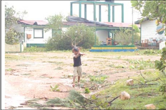
Pabellón de Aulas
