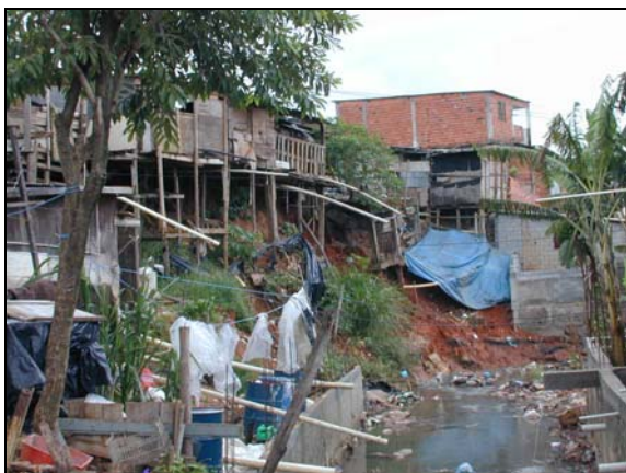
Foto 15: Solapamento de margem fluvial, em afluente do ribeirão Pirajuçara, atingindo moradias de baixo padrão construtivo.
