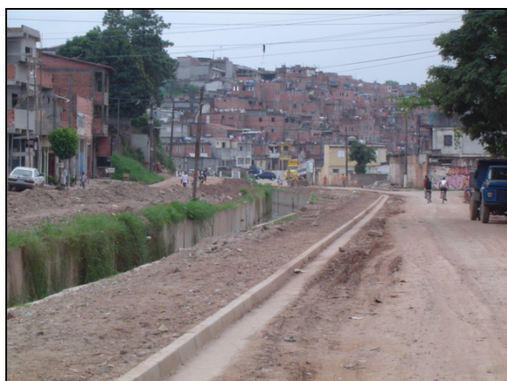
Foto 51: Trecho do ribeirão Pirajuçara em fase de obra de canalização.
