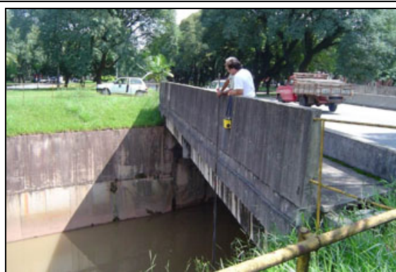
Medição de vazão e coleta de sedimentos do Pira 2.
