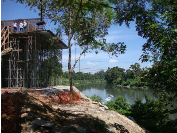
FOTO 28: Rio Tietê e a Foz do Rio Cotia. Construção de ponte até os condomínios Alphaville. Barueri-SP. Foto: Julia R. Leite (2011).
