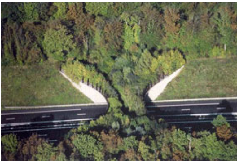
FIGURA 22: Ponte para Travessia de Animais 26 Motorway na Hardt Forest, Alemanha. Informações obtidas em: http://graemelaidlaw.wordpress.com/ .Acessado em 15/3/2012
